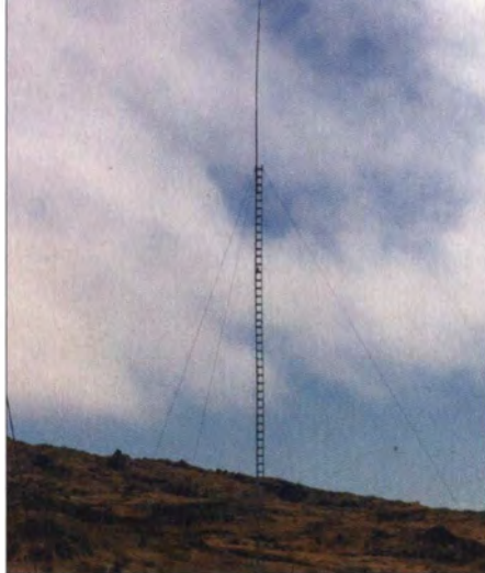
Unser „Flammerwerfer“, die 28 m hohe Vertikal für 160 m
