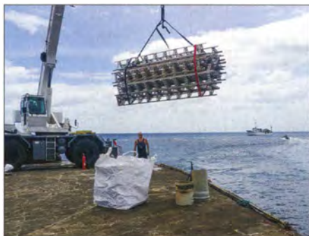
Einige der jeweils 3 m langen Mastteile, die als Träger für unsere Antennen dienen
