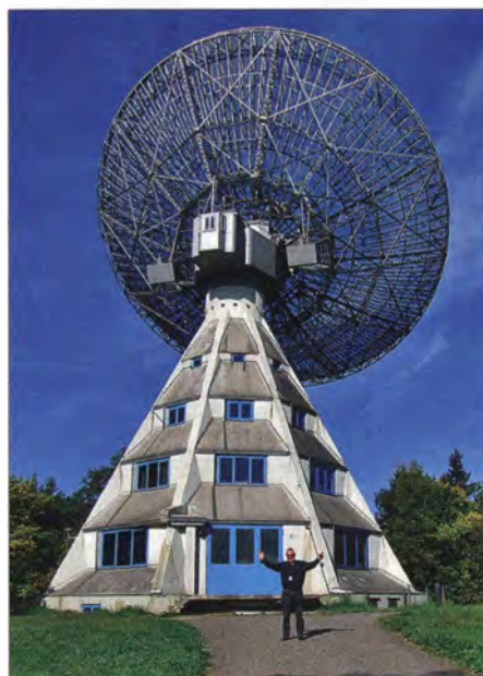
25-m-Spiegel des Astropeilers Foto: DF2BC
